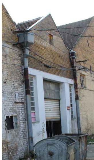
Slika 9 – objekat br. 7 na kat. parceli broj 7335/1
