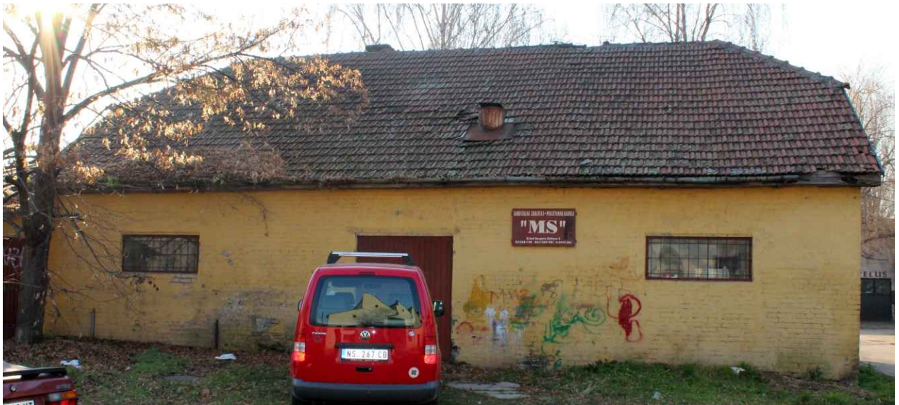
Slika 12 – objekat br. 10 na kat. parceli broj 7335/1
