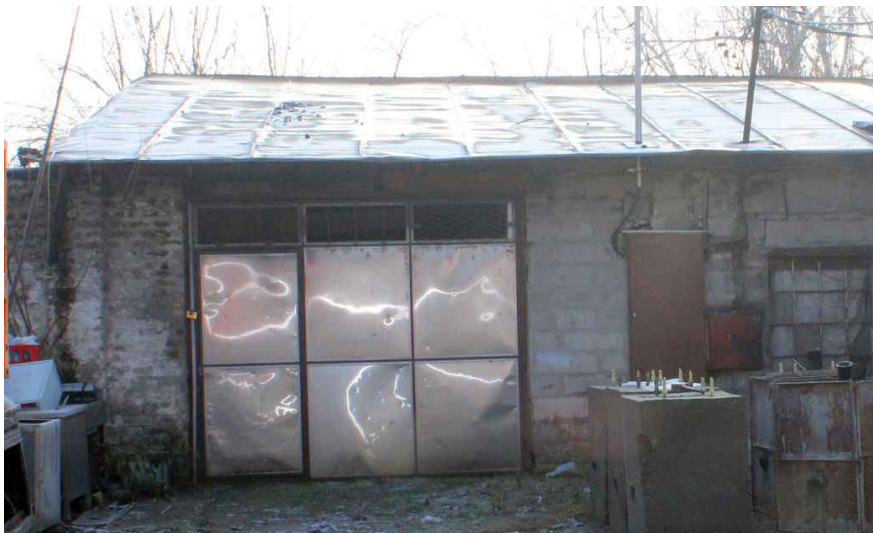
Slika 28 – objekat br. 24 na kat. parceli broj 7335/1
