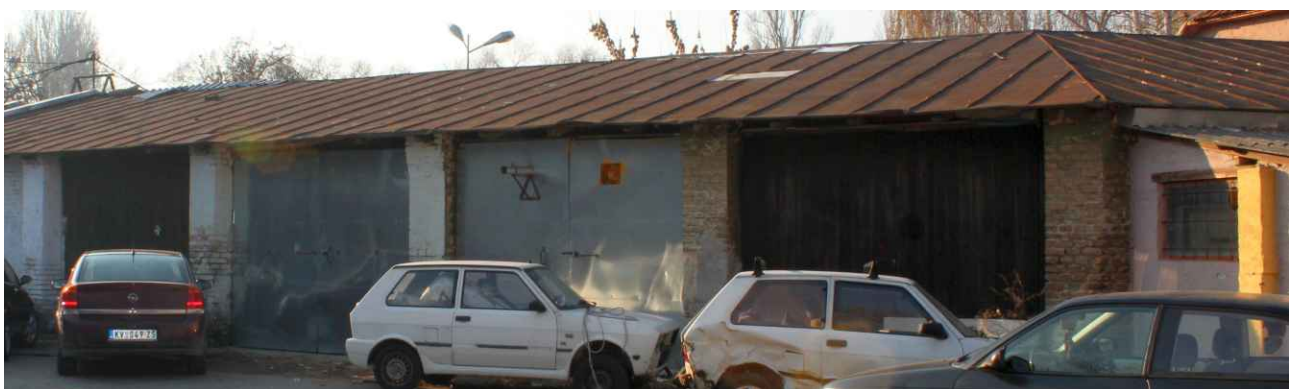
Slika 13 – objekat br. 11 na kat. parceli broj 7335/1
