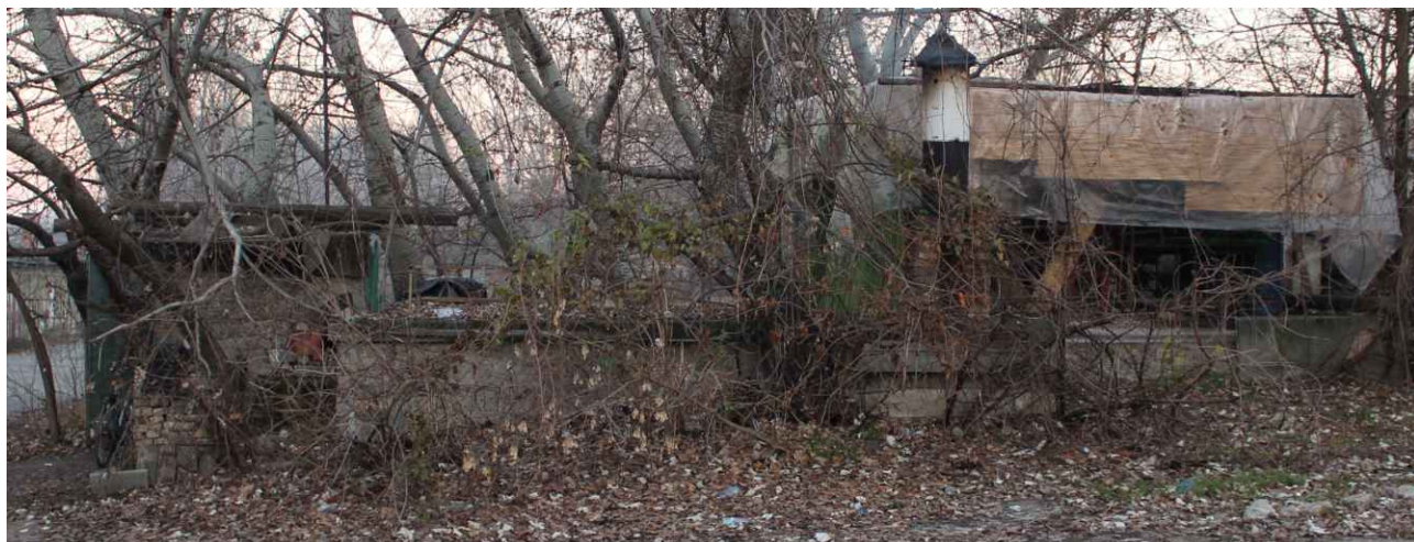
Slika 41 – objekat br. 1 na kat. parceli broj 7335/3
