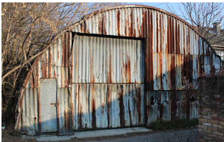
Slika 32 – objekat br. 27 na kat. parceli broj 7335/1
