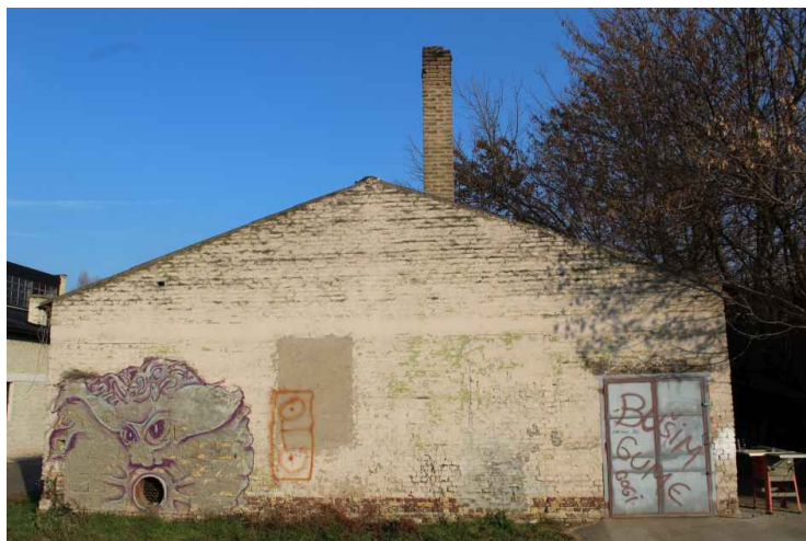
Slika 33 – objekat br. 28 na kat. parceli broj 7335/1
