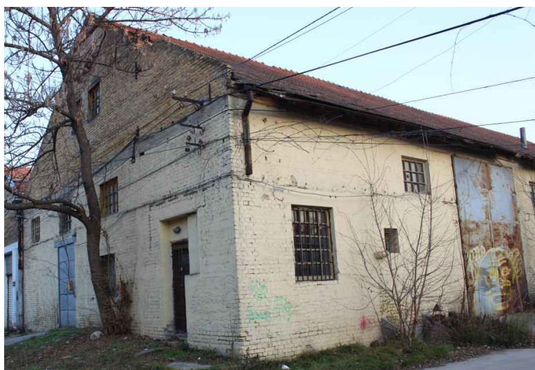
Slika 10 – objekat br. 8 na kat. parceli broj 7335/1
