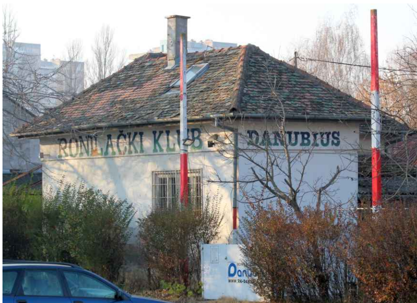
Slika 6 – objekat br. 4 na kat. parceli broj 7335/1
