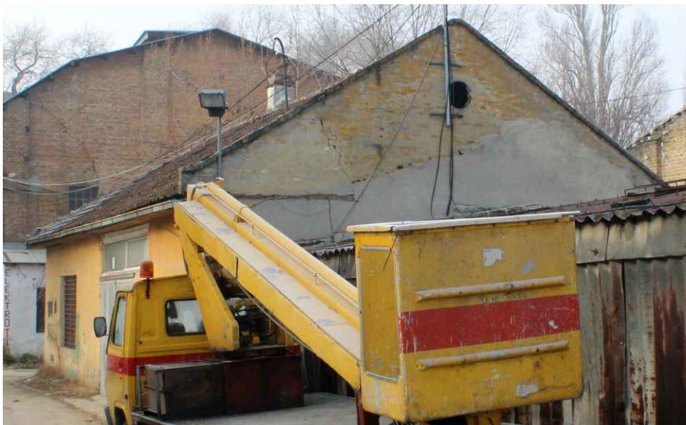
Slika 22 – objekat br. 19 na kat. parceli broj 7335/1
