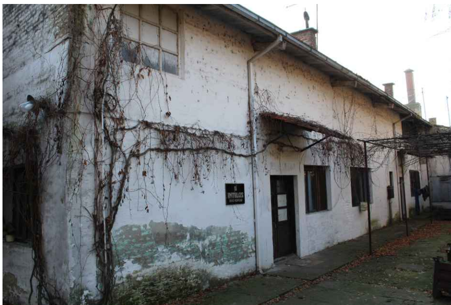
Slika 36 – objekat br. 2 na kat. parceli broj 7335/2
