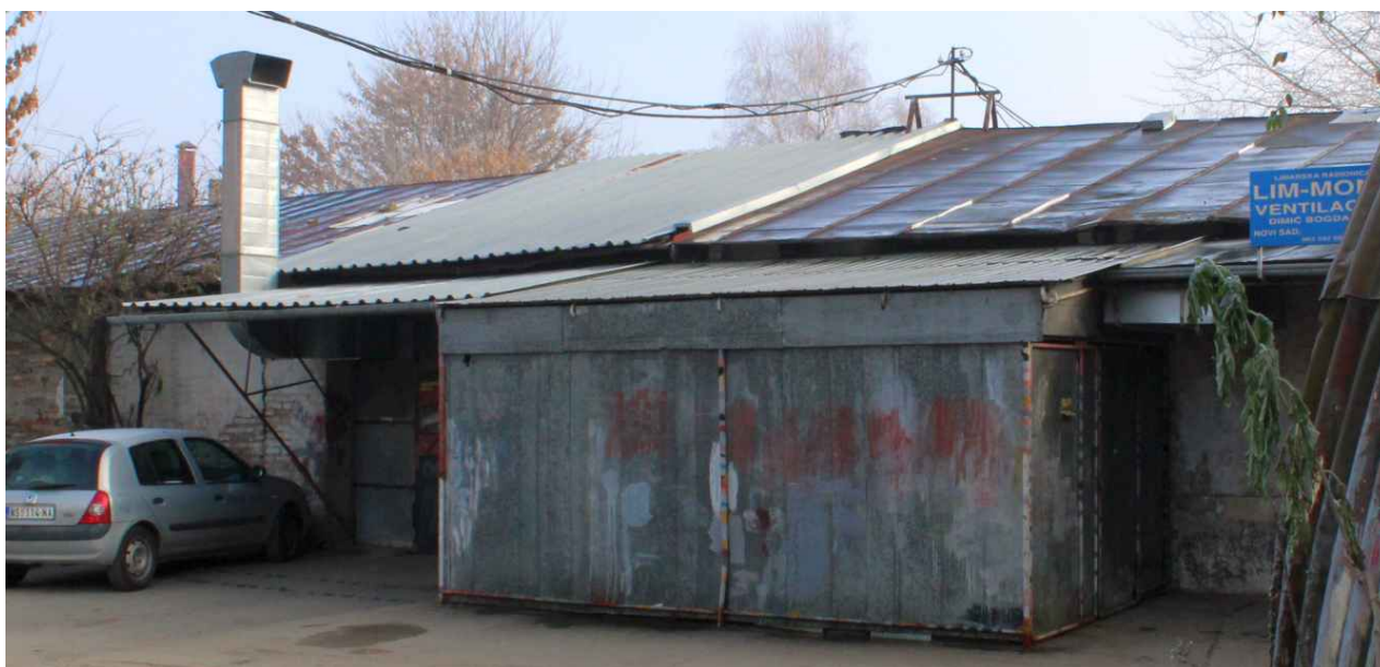
Slika 14 – objekat br. 12 na kat. parceli broj 7335/1
