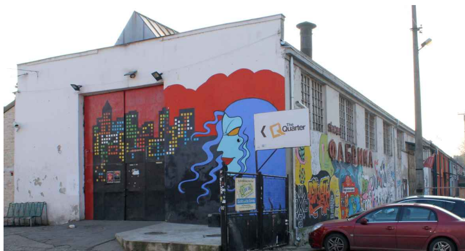
Slika 31 – objekat br. 26 na kat. parceli broj 7335/1
