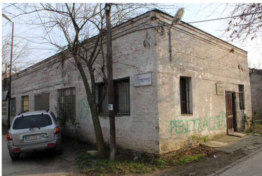
Slika 25 – objekat br. 22 na kat. parceli broj 7335/1
