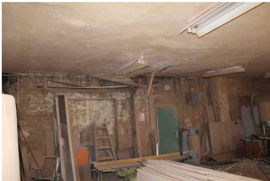
Slika 26 – deo unutrašnjosti objekta br. 22 na kat. parceli broj 7335/1
