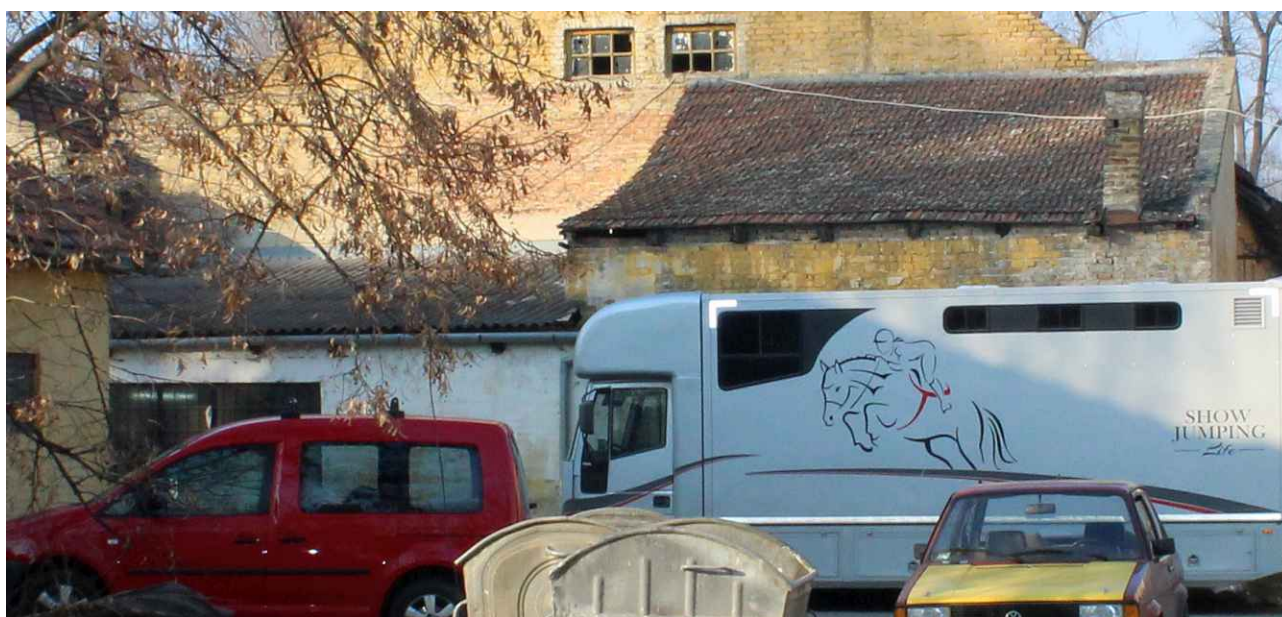
Slika 11 – objekat br. 9 na kat. parceli broj 7335/1
