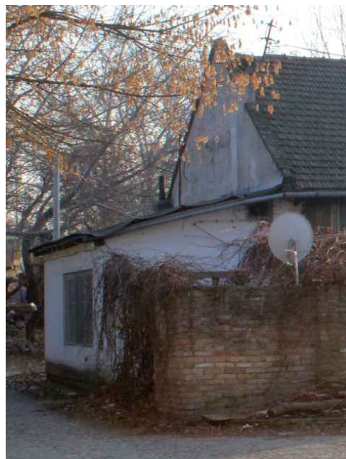
Slika 4 – objekat br. 2 na kat. parceli broj 7335/1
