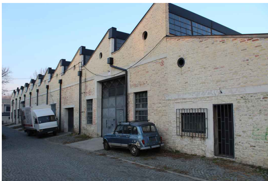
Slika 7 – objekat br. 5 na kat. parceli broj 7335/1
