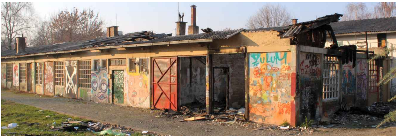
Slika 39 – objekat br. 5 na kat. parceli broj 7335/2
