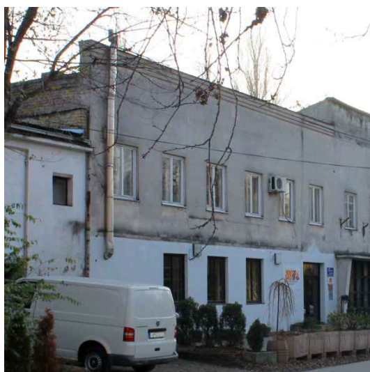
Slika 48 – objekat br. 11 na kat. parceli broj 7335/4
