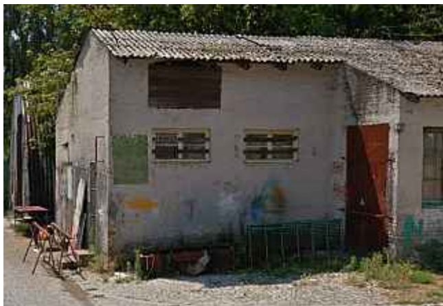
Slika 47 – objekat br. 10 na kat. parceli broj 7335/4
