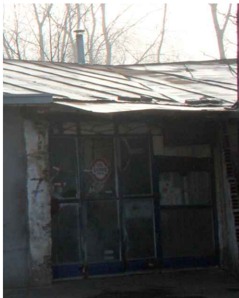
Slika 15 – objekat br. 13 na kat. parceli broj 7335/1
