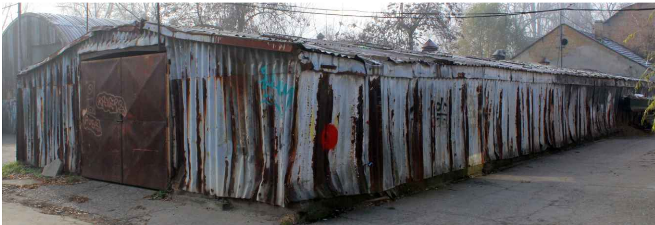
Slika 21 – objekat br. 18 na kat. parceli broj 7335/1
