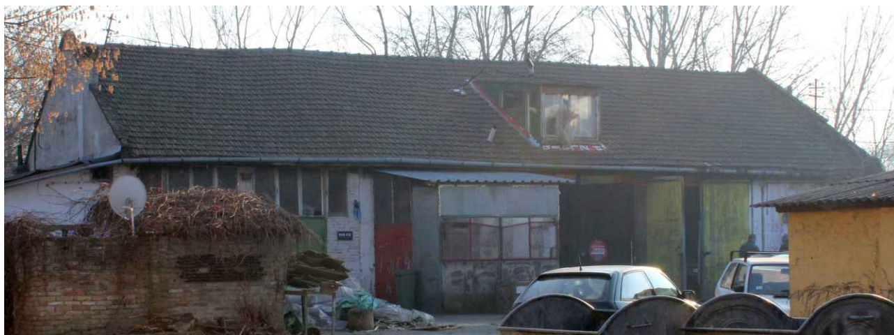
Slika 5 – objekat br. 3 na kat. parceli broj 7335/1
