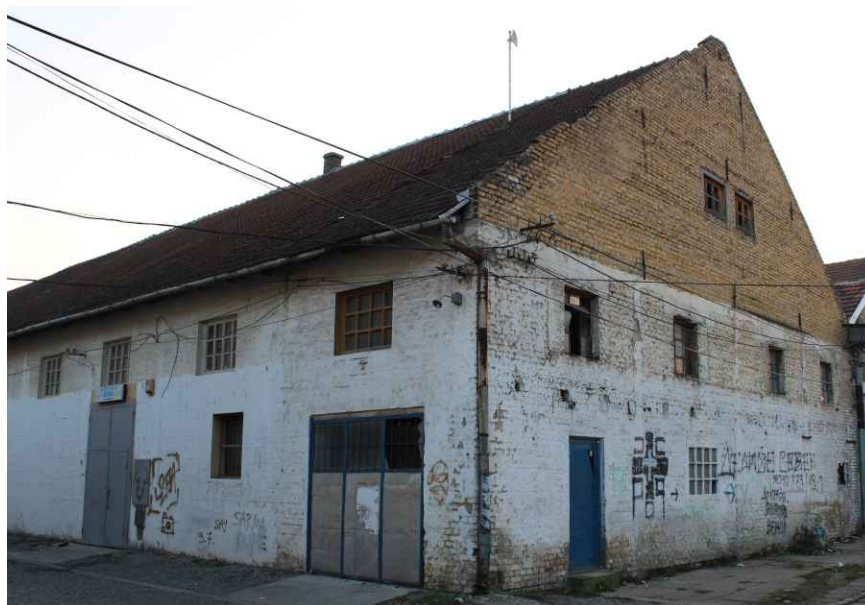
Slika 8 – objekat br. 6 na kat. parceli broj 7335/1
