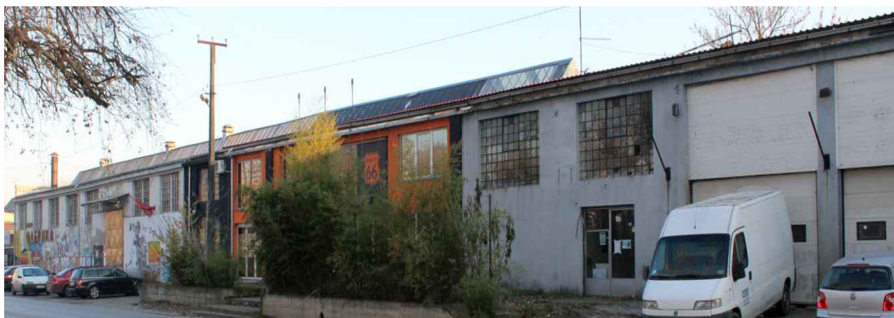
Slika 45 – objekt br. 6 na kat. parceli 7335/4
