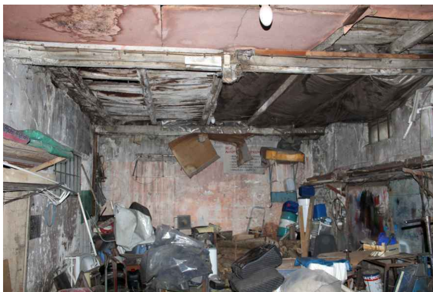
Slika 20 – unutrašnjost objekta br. 17 na kat. parceli broj 7335/1
