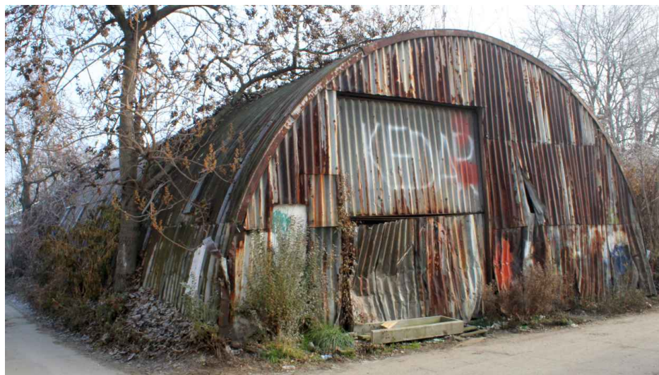
Slika 18 – objekat br. 16 na kat. parceli broj 7335/1
