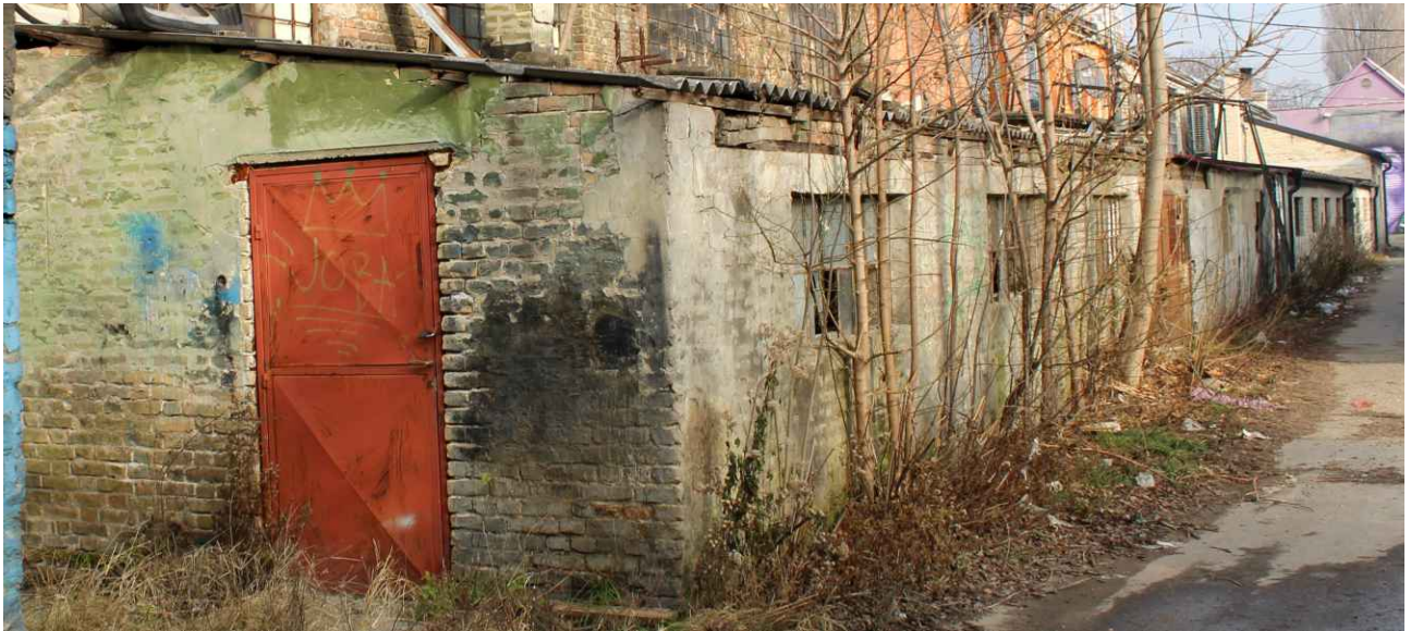
Slika 3 - objekat br. 1 na kat. parceli broj 7335/1
