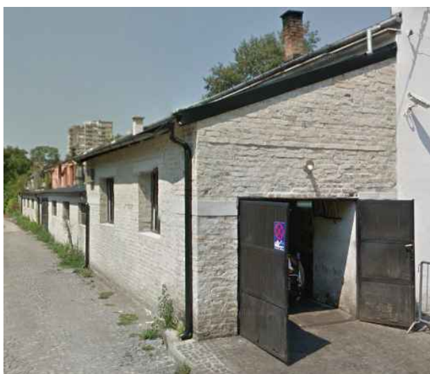
Slika 2 – objekat br. 1 na kat. parceli broj 7335/1
