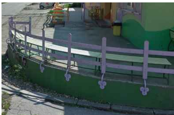
Slika 42 – objekat br. 1 na kat. parceli broj 7335/4
