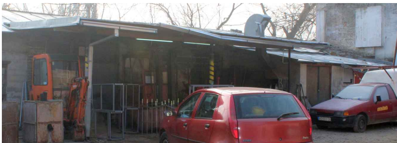
Slika 27 – objekat br. 23 na kat. parceli broj 7335/1
