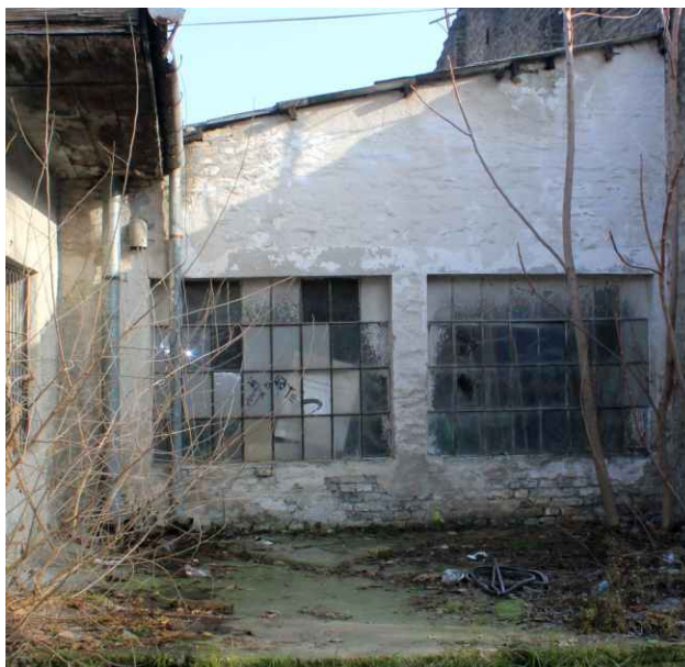
Slika 24 – objekat br. 21 na kat. parceli broj 7335/1
