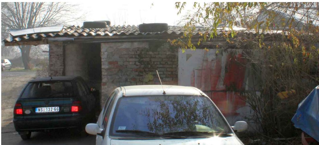
Slika 17 – objekat br. 15 na kat. parceli broj 7335/1
