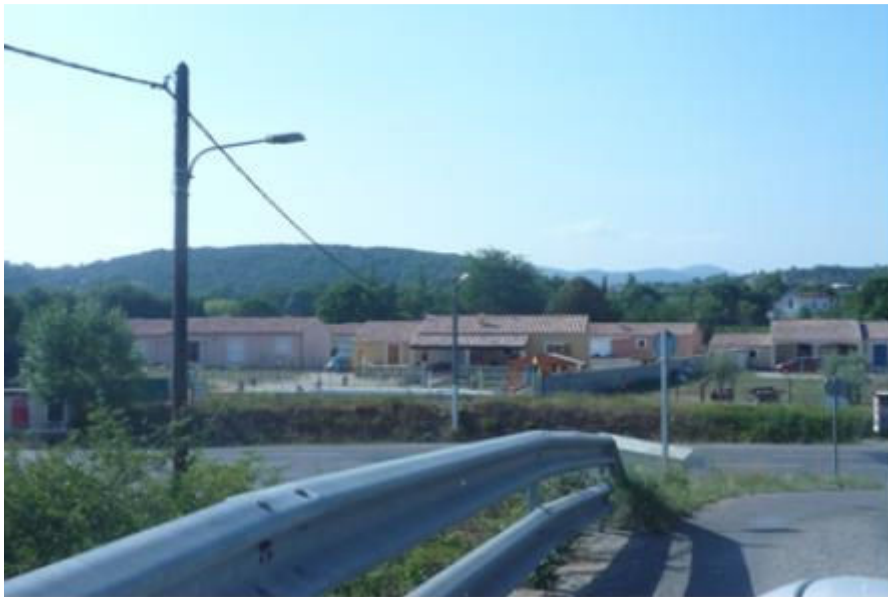
Figure 9 : Vue du nord ouest du site (8)
