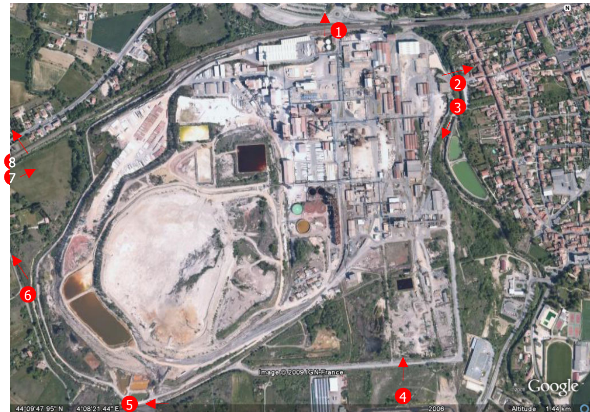
Figure 1 : Localisation des vues du voisinage et de RHODIA OPERATIONS
