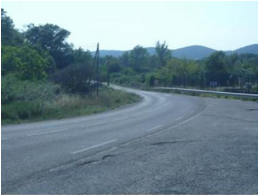
Figure 6 : Vue de la limite sud de la plateforme (5)
