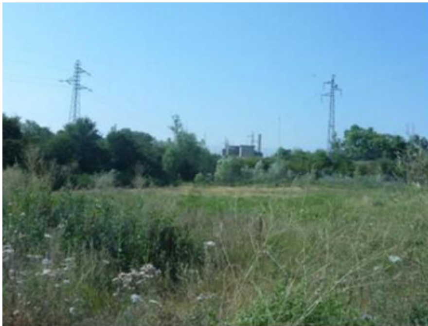
Figure 5 : Vue du sud du site (4)
