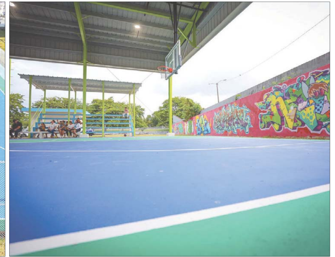
Cancha en la Urb. Bay View en Cataño inversión de $476,788
