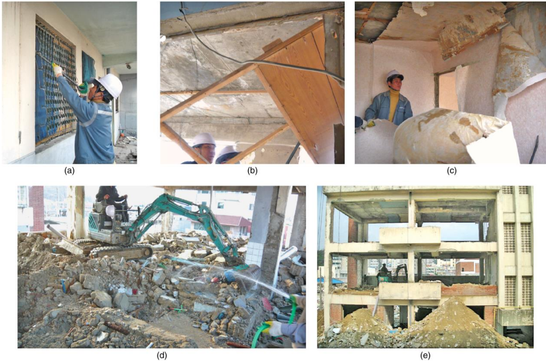
Φωτογραφία 4Α.1: Επιλεκτική Κατεδάφιση
