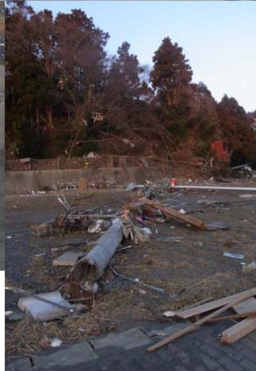
破断したポール。
