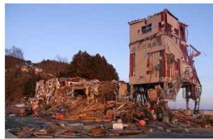
木造。土台ごと流された事例。 海岸付近の製氷所。スケルトンが残った事例。
