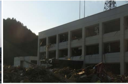
基礎から外れず残った鉄骨。外壁なし。
