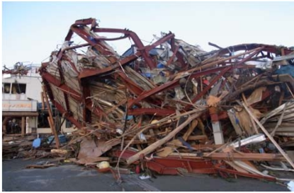
基礎から外れず残った鉄骨。外壁なし。
