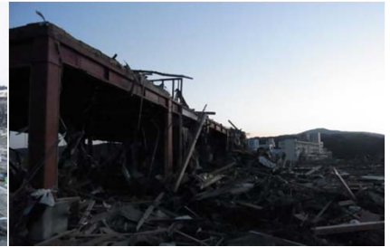
スケルトンが歪まず残った鉄骨。外壁なし。
