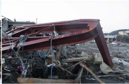
基礎から外れず残った鉄骨。外壁なし。
